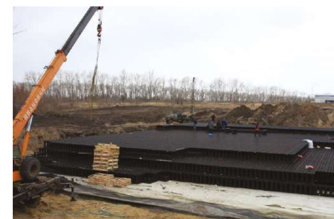
АККУМУЛИРУЮЩАЯ ЁМКОСТЬ ОБЪЕМОМ 6050 М 3 В СОСТАВЕ ОЧИСНЫХ СООРУЖЕНИЙ КАНАЛИЗАЦИИ ИНДУСТРИАЛЬНОГО ПАРКА «МАСЛОВСКИЙ», Г. ВОРОНЕЖ
