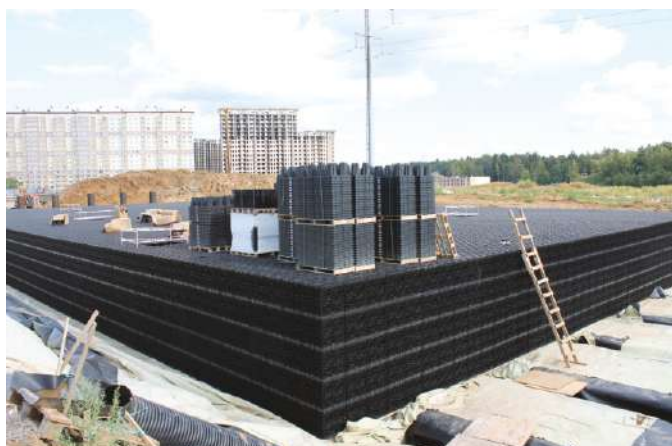
АККУМУЛИРУЮЩАЯ ЁМКОСТЬ ОБЪЕМОМ 6050 М 3 В СОСТАВЕ ОЧИСНЫХ СООРУЖЕНИЙ КАНАЛИЗАЦИИ ИНДУСТРИАЛЬНОГО ПАРКА «МАСЛОВСКИЙ», Г. ВОРОНЕЖ
