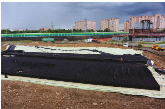
АККУМУЛИРУЮЩАЯ ЁМКОСТЬ ОБЪЕМОМ 6050 М 3 В СОСТАВЕ ОЧИСНЫХ СООРУЖЕНИЙ КАНАЛИЗАЦИИ ИНДУСТРИАЛЬНОГО ПАРКА «МАСЛОВСКИЙ», Г. ВОРОНЕЖ
